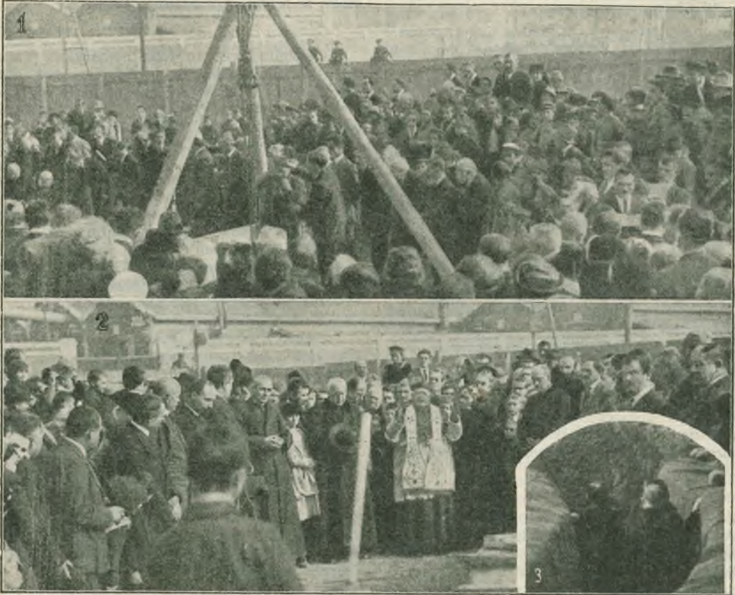
La prima pietra nelle fondamenta del nuovo tempio a Borgo S. Paolo.
